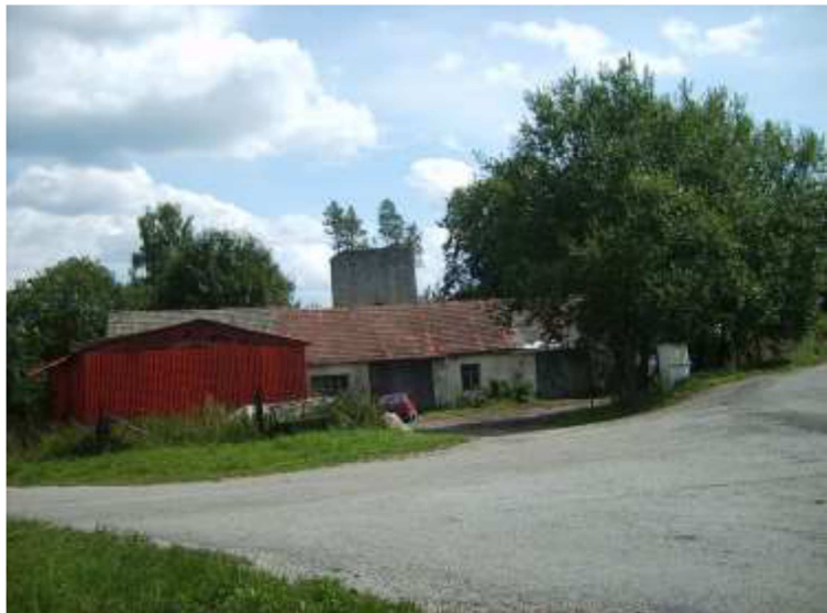
Obr. 2 Stav před zbouráním – zřejmě dílna Státního statku.
